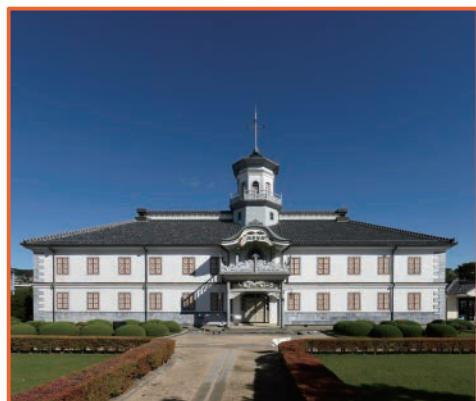
2: 旧開智学校校舎(国指定重要文化財) 1876年 立石清重
