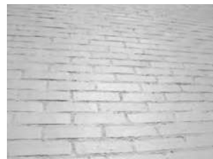
真っ白なレンガの外壁
